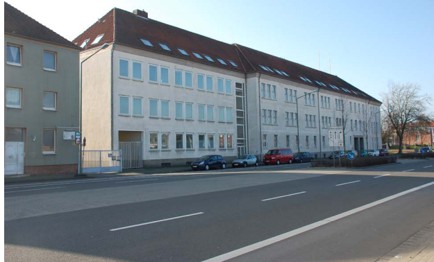
Das ehemalige Finanzamt Osnabrück-Land an der Hannoverschen Straße.
